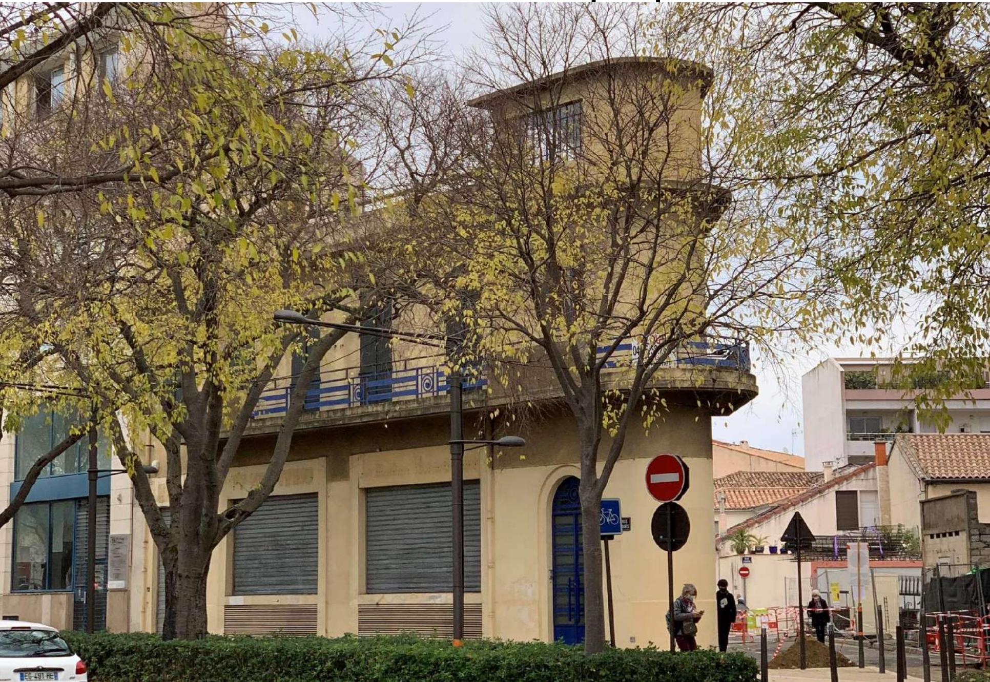
**Une proue et des coursives à garde corps de tubes et tôle à motifs en fer forgé**
