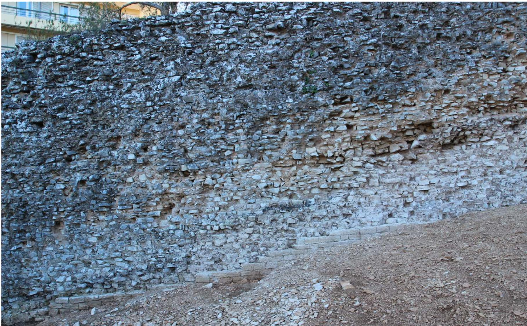
*« Les limites de banchées marquent les arrêts de travail et correspondent aux phases de séchage du mortier.*
